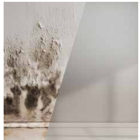
Eine fehlende oder defekte Außenabdichtung lässt Feuchtigkeit aus dem Erdreich ungehindert in das Mauerwerk eindringen
